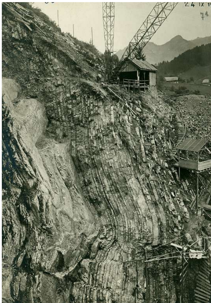
Fig. 5: Calcaires en petit bancs, redressés en position verticale, bien visibles lors de la construction du barrage de Montsalvens en 1919.
